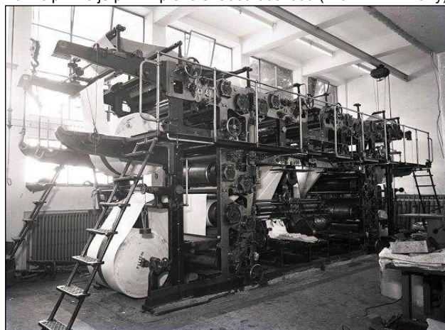
Rotačka firmy Albert & Cie AG chrlící složené výtisky novin, 1938
