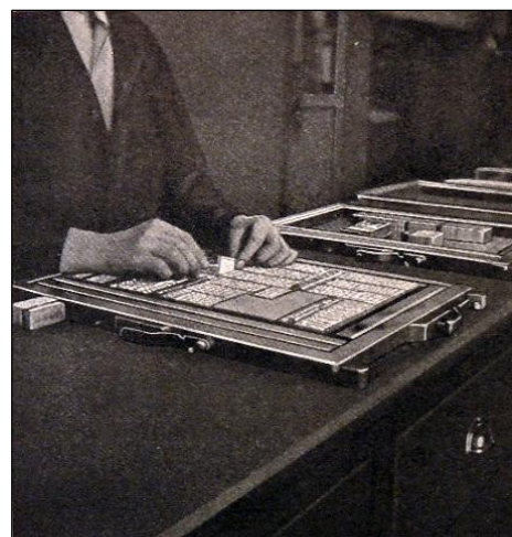
Zalomení stránky před odlitím válce do rotačky
